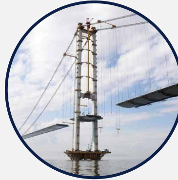
ASMA KÖPRÜ, KÖPRÜ VE ÜST GEÇİTLERİN BAKIMLARI
