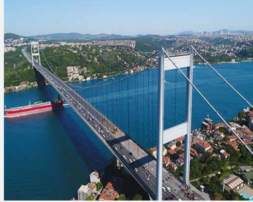
15 Temmuz Şehitler Köprüsü Tabliye kumlama ve Membran Uygulaması
